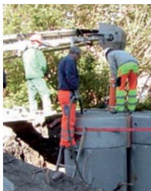
De 3 kloakrør fyldes med beton
